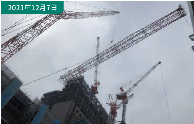
⑤仮設工事 450tクレーン車にてタワークレーンを解体しました。
