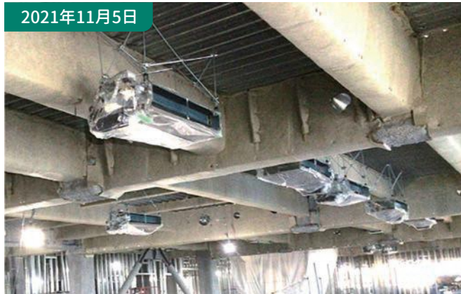
③天井内機器吊込工事 部屋の空調を行う機器を、天井内に吊込みます。
