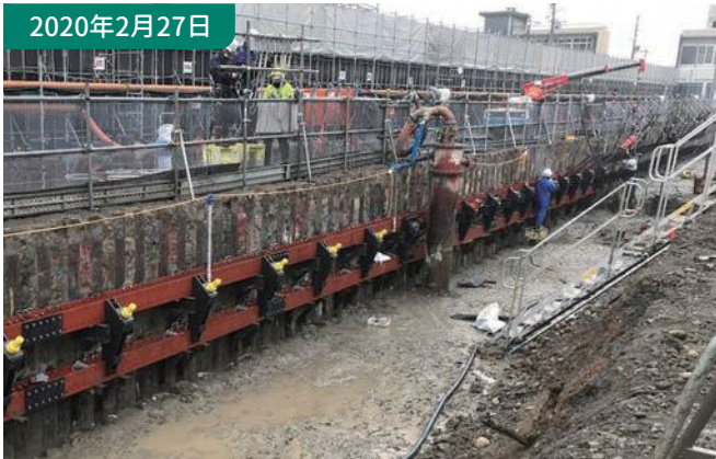
③山留工事（腹起し） 打ち込んだアンカーと山留壁をつなぐ工事。施工後も山留壁が倒れてきていないか毎日チェックする必要があります。
