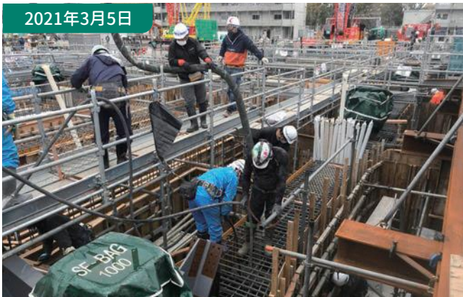
⑧コンクリート工事 ポンプ車を用いて建物の基礎・地中梁のコンクリートを打設します。
