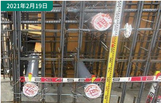
③スリーブ工事 地下ピット内のコンクリート壁や梁に電気配管を通すため、コンクリート打設前に予め口径の大きい配管を入れる工事です。
