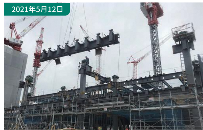
⑧鉄骨工事 建物の骨組みとなる鉄骨を建てていきます。
