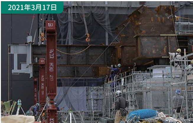
⑨鉄骨工事 工場で製品検査に合格した製品を現場で取りつける工事。搬入車両が多いため、1日の取り付ける量を計画し、タイムリーに施工を行います。
