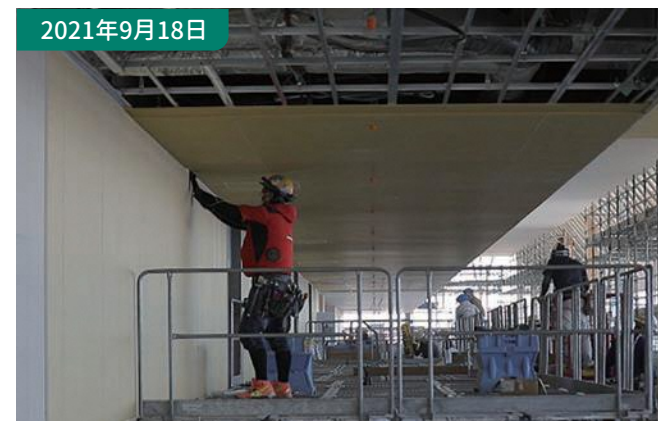
⑧内装工事（ボード張り） クロスや塗装などの下地となる壁を組み立てる工事。壁の仕様により様々な張り方があるため、混同しないように注意して施工します。
