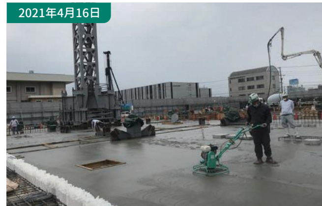
④コンクリート工事 1階床コンクリート打設状況です。
