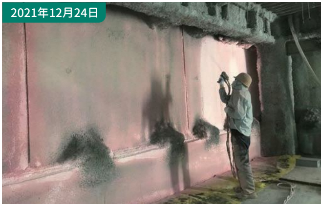
⑦断熱工事 断熱性能を確保するために発泡ウレタンを吹付しました。
