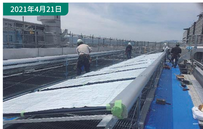
⑥太陽熱集熱器搬入 日射時間が多い地域特性を利用して、太陽熱を空調に利用します。
