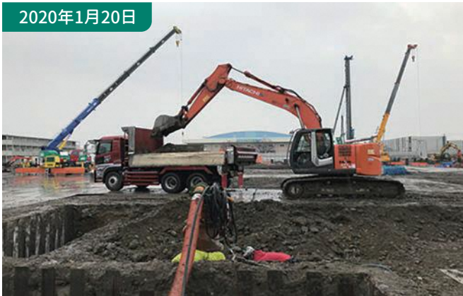
①掘削工事 地下躯体工事を進めるために余分な土砂を掘削する工事。掘り進め方、ダンプのルート、残土ヤードの計画などが必要です。
