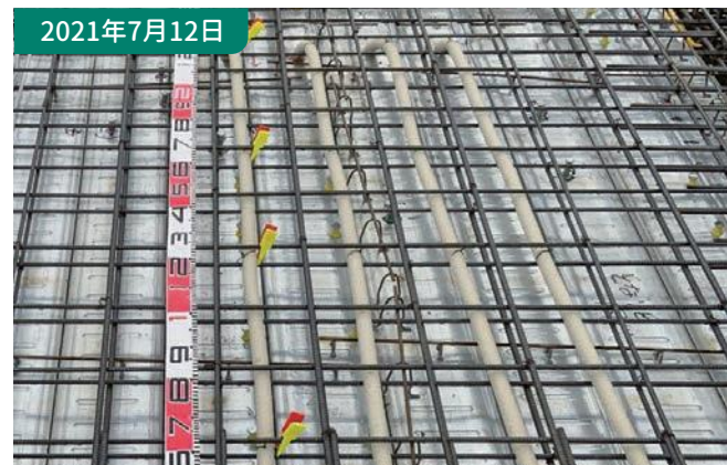
②コンクリート内配管工事 部屋内の机や家具にコンセントや電話の配線をするため、コンクリート打設前に予め通線用の配管を入れる工事です。
