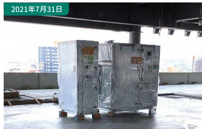
⑥大型機器搬入工事 外壁工事より先行し、大型空調機を搬入します。
