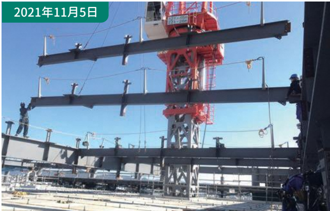
②鉄骨工事 鉄骨建方状況です。地上で30mの梁を組み立ててタワークレーンにて取り付けました。
