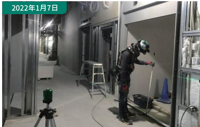
⑧鋼製建具工事 内部鋼製建具取付状況です。
