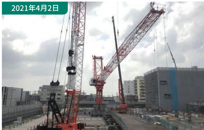
①仮設工事 建設資材を揚重する為に720tタワークレーンを組立て設置します。
