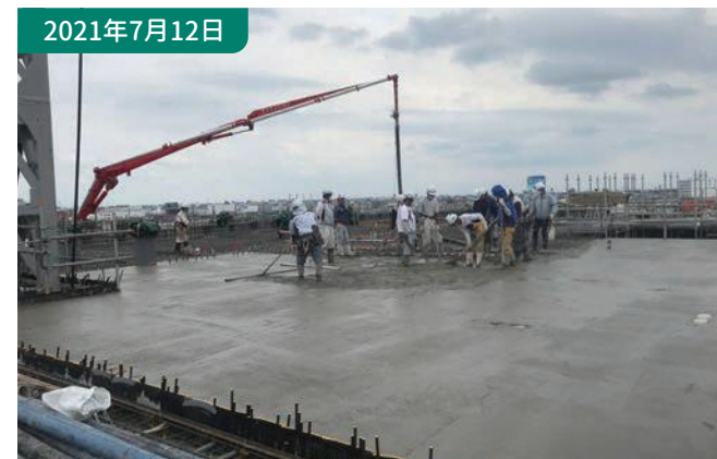
③コンクリート工事 5階スラブコンクリート打設状況です。
