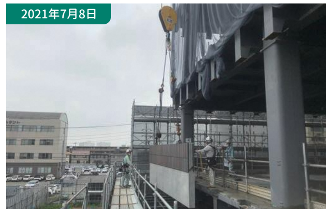
①PC工事 2階外壁PC版、取付状況です。
