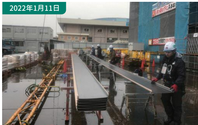
⑨屋根工事 屋根折板を現場で成形し、クレーンにて荷上げ後、屋根葺き施工しました。
