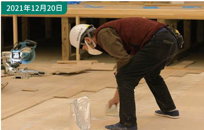
⑥床工事（フローリング貼り） 床仕上げ工事。床の下地が悪いと仕上げ面に段差が生じるため、着手前に下地を確認する必要があります。
