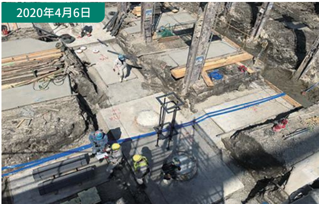
⑦土工事（均らしコン打設） 基礎の正確な位置出しや、型枠を建て込めることができるようにする工事。均らしコンクリートに強度はなく、鉄筋も入っていません。
