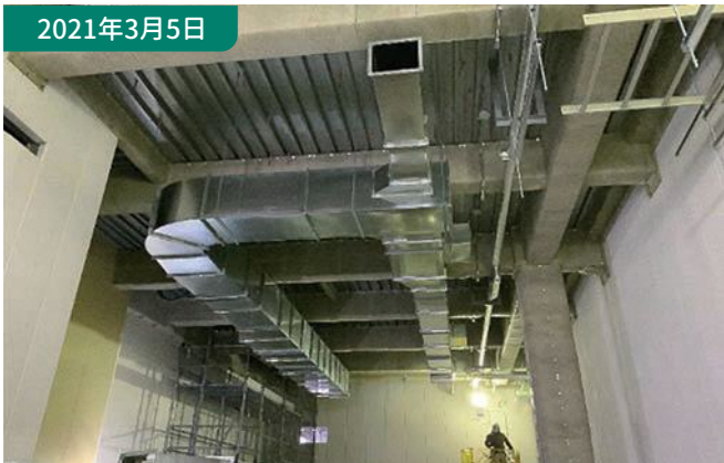
⑦ダクト工事 給排気、空調の風を送るため、亜鉛鉄板製のダクトを低い所では2.5m、高い所では5mの高さへ吊込みを行います。
