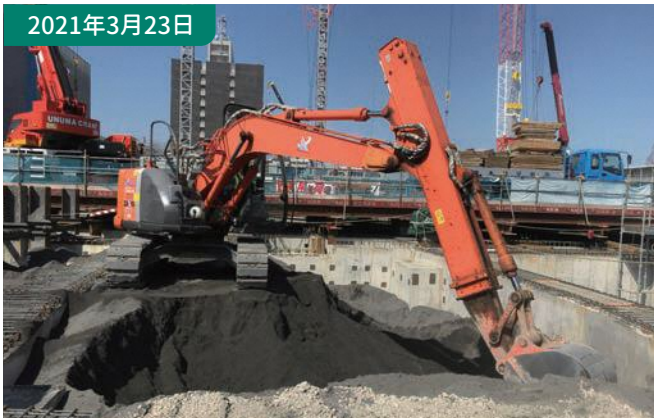
⑩土工事 基礎構造を作った後に土砂を転圧しながら埋め込みます。
