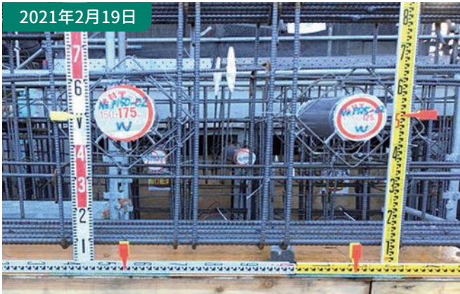
④スリーブ工事 地下ピット内のコンクリート壁や梁に設備配管を通すため、コンクリート打設前に予め口径の大きい配管を入れる工事です。
