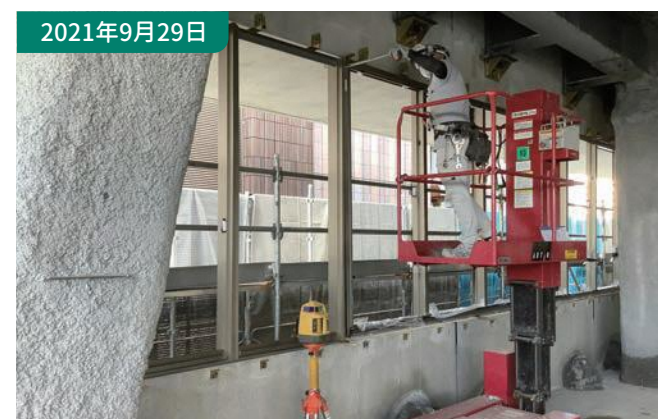
⑩外部建具工事 外部アルミサッシ取付状況です。
