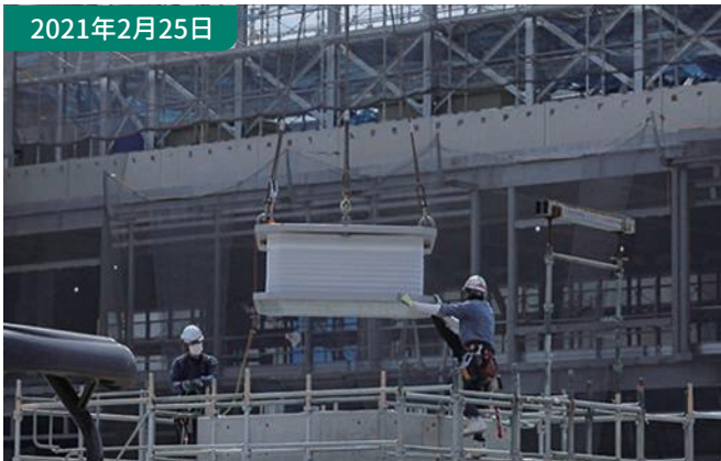
⑥免震工事 免震装置を取り付ける工事。鉄骨精度にも影響する恐れがあるため、取付前・取付後・鉄骨施工後に測定を行い、慎重に工事を進める必要があります。
