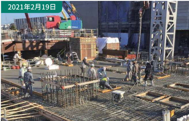
②コンクリート工事 1Fスラブをコンクリートポンプ車を用いて打設を行います。
