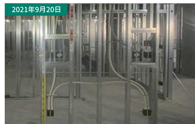
⑨軽量間仕切内配管工事 部屋を間仕切る壁の中にコンセントや電話の配線をするため、壁が仕上がる前に予め通線用の配管やボックスを取付ける工事です。
