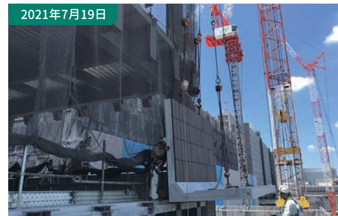
④PC工事 4階外壁PC版取付状況です。
