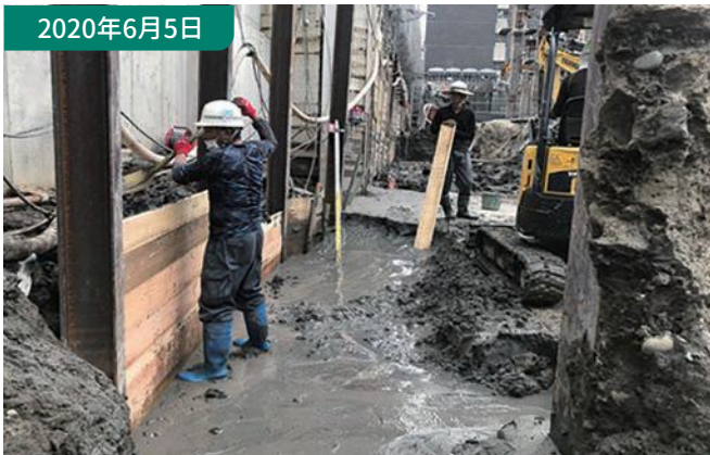
⑧山留工事（親杭横矢板工法） H鋼を打ち込み、間に矢板を敷き込み山留壁を形成する工事。
