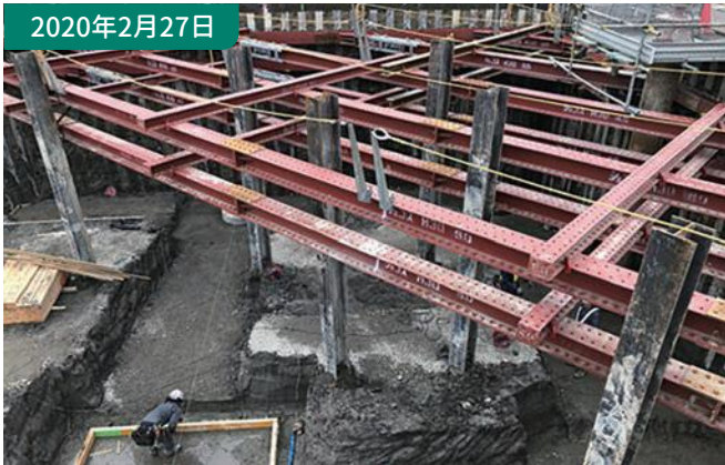
④山留工事（水平切梁工法） 山留壁が倒れてこないように「つつぱり」を施工する工事。
