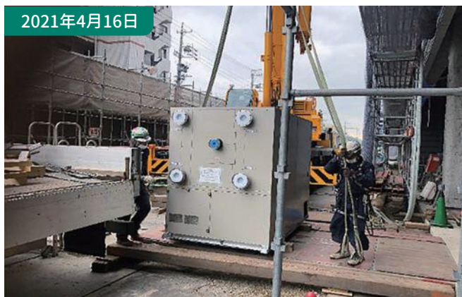
⑤水冷ヒートポンプチラー搬入 年間を通して一定の温度である地下水熱を利用する水冷ヒートポンプチラーを設置します。
