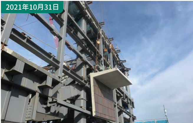
①PC工事 6階外壁PC版取付状況です。
