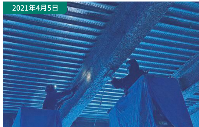
②耐火被覆吹付工事 耐火性、断熱性の高いロックウールで鉄骨の骨組みを被覆する事で火災時の建物の倒壊を防ぎます。
