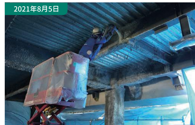
⑦耐火被覆工事 鉄骨部分の耐火被覆を行うためにロックウールを吹き付けています。
