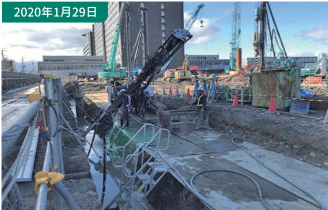
②山留工事（アースアンカー） 事前に施工した山留壁が倒れてこないように地盤にアンカーを打ち込む工事。打ち込む先に障害物がないか確認します。
