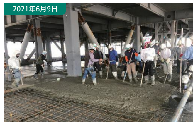
⑨コンクリート工事 2階床スラブコンクリート打設状況です。
