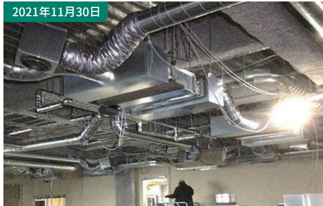
④天井内配管ダクト吊込工事 部屋天井内の空調機にダクト、配管を吊込、接続。空調機、配管、ダクトが繋がり、部屋を空調します。
