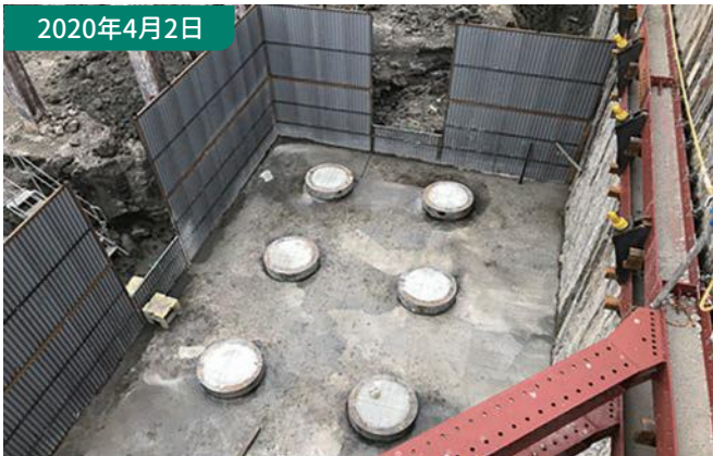
⑥型枠工事（RADIX工法） 在来型枠と違い、鋼製型枠を用いて型枠を組み立てる工事。鋼製型枠にすることで先行埋め戻しが可能となります。
