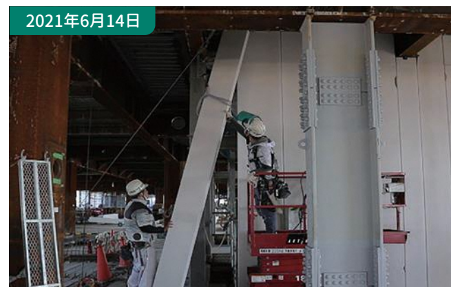
⑩ALCパネル工事 軽量気泡コンクリートパネルを取り付ける工事。耐火性能を持ち合わせたパネルで、取り扱いやすく、様々な箇所で使用されています。
