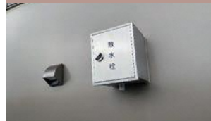
5、6階：バルコニー 散水栓
